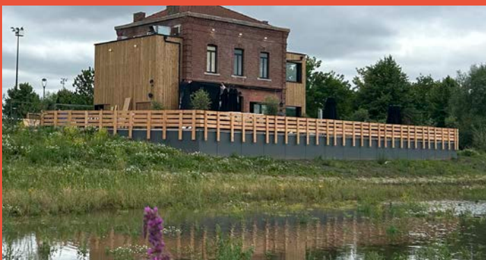
VILLE RENOUVELÉE – Parc marais fréquenté (livraison août 2025)
