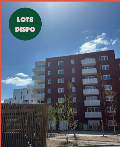
CARRERE – Programme de 141 logements «Nouvel'Aire» (livraison septembre 2025)
