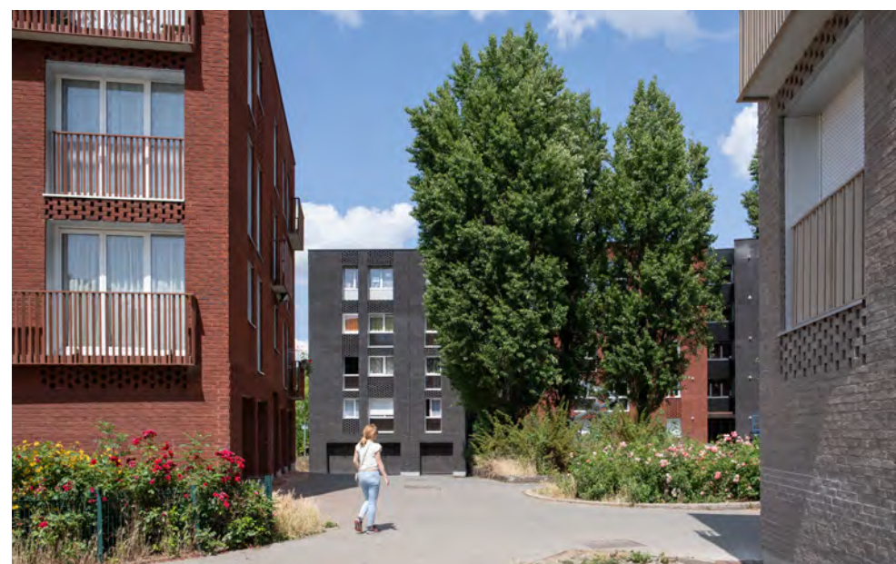
Résidence Bocage 3 en cours de rénovation (Vilogia).
